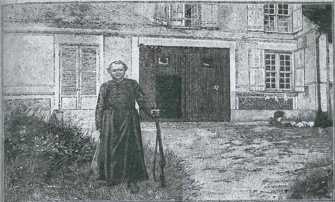
Fig. 8. — PHOTOGRAPHIE DE M. L'ABBÉ SCHNEBELIN, VENANT DE TIRER LES COUPS DE FUSIL DANS LES MEUBLES ET LES MURS DE LA MAISON DE VALENCE-EN-BRIE, POUR EN CHASSER LES ESPRITS. (Phot. communiquée par M. G. Méry.)
