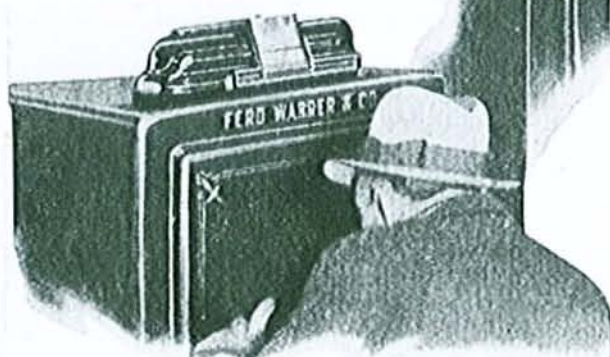
L'invention d'un homme de Chicago, un pistolet à gaz lacrymogène, dans le cercle, décharge quand la plaque avant du coffre-fort est entamée par le perceur de coffre, complétant le circuit électrique qui envoie l'alarme de police. La victime aveuglée est facilement capturée et emprisonnée.
